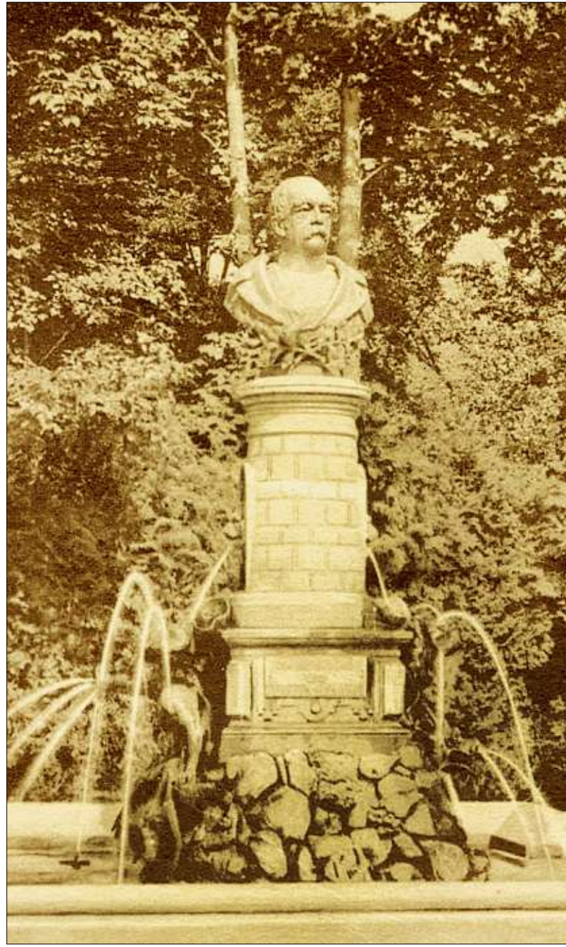
Der 1896 fertiggestellte Bismarckbrunnen an der Bahnhofstraße.
