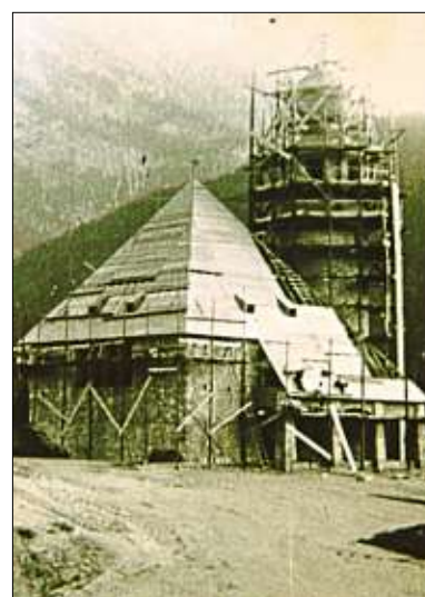
Im Herbst 1949 war der Rohbau fertig.
