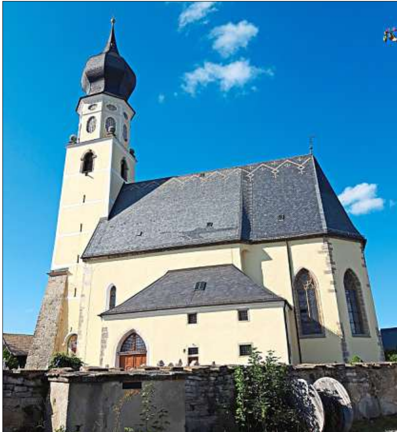
Die Ansicht des Gotteshauses von Süden aus. Links ist die Stützmauer des Turms zu erkennen.
