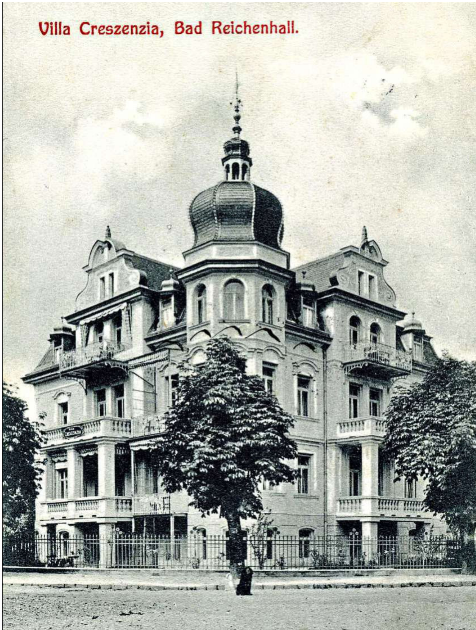
Postkarte mit „Villa Creszenzia“: Dieses Haus gehörte unter anderem zu ihrem Besitz.
