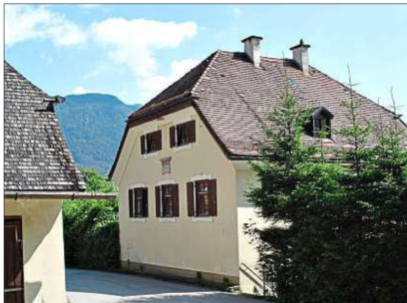
Das Brunnhaus Fager an der ersten Steigung der Soleleitung in Karlstein.
