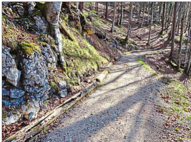
Gut erhaltene Deicheln in der Nähe des Hochbehälters Nagling.
