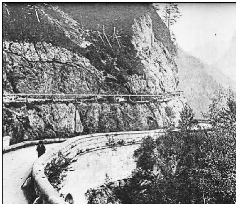
Über der Weißbachschlucht verlief die Soleleitung oberhalb des „Neuweges“ geschützt durch Lawinverbauungen.
