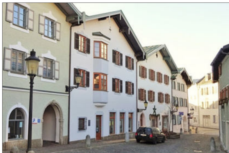
Wohnhäuser aus den 1980er-Jahren in der Sebastianigasse.
