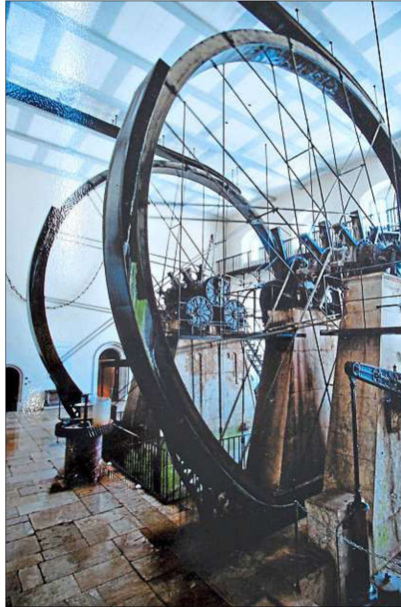
13 Meter hohe Wasserräder treiben die Solepumpen an.
