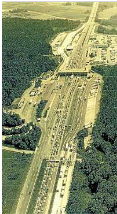
Der Walsberg nach den Umbauarbeiten 1993.
